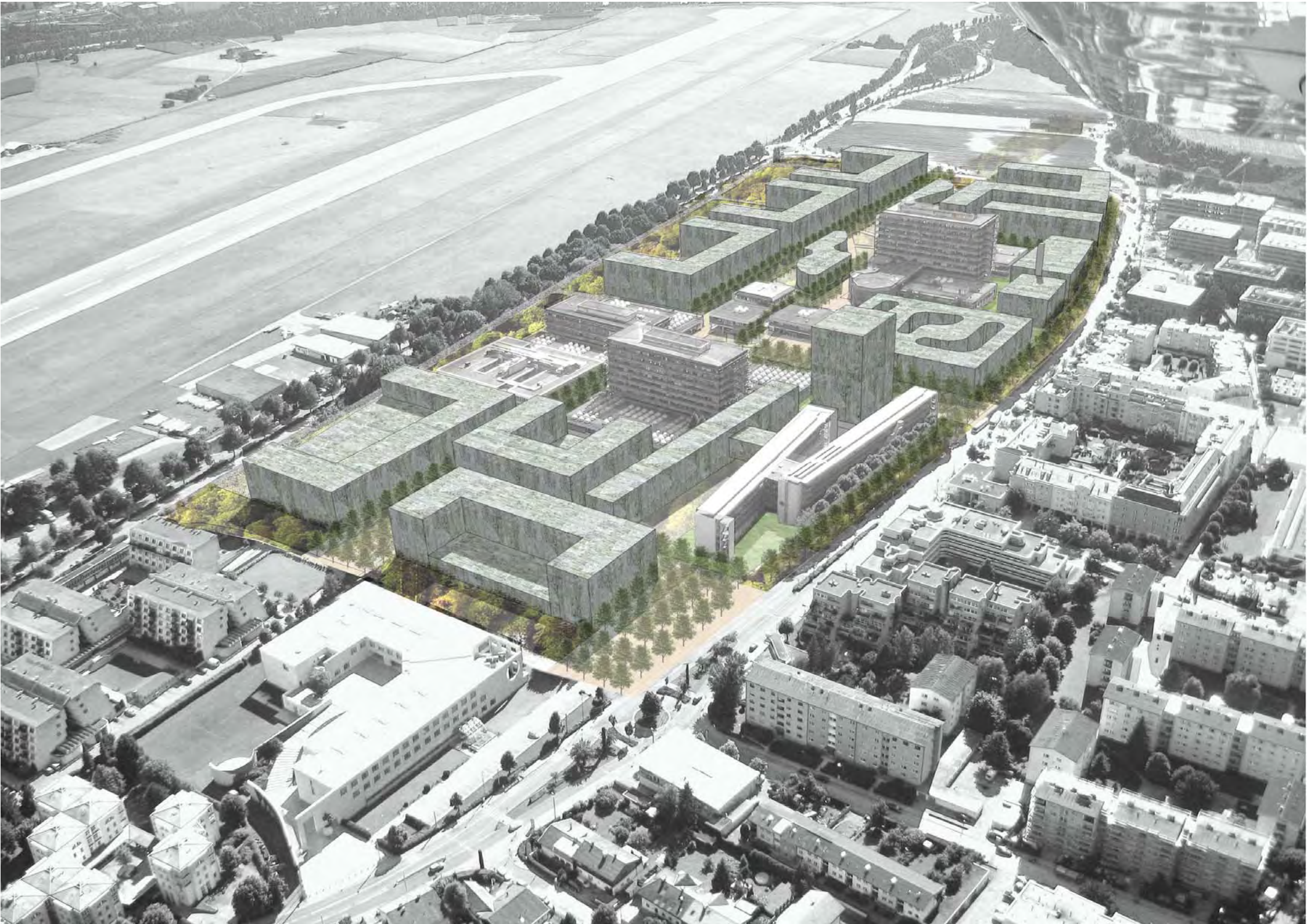
Bebauungsstruktur in letzter Bauphase
